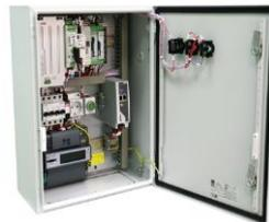
Рисунок 1.11.3 – Блок запуска оповещения электромеханической сирены (ПГМ-БЗО-ЭС).
