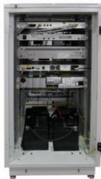
Рисунок 2.5.3 – Устройство запуска, управления и мониторинга «Инфо-УКБ».
