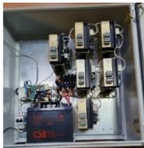
Рисунок 1.8.3 – Усилительно-коммутационный блок УКБ СГС -22МЕ ХХХН(У).
