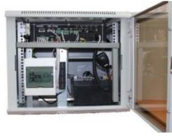
Рисунок 1.5.10 – Комплекс громкоговорящего оповещения на базе УКБ «ГРОМ».
