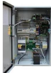
Рисунок 1.5.8 – Устройство управления электросиренами ИТК ОС УЭС.
