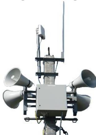
Рисунок 1.8.7 - Устройство усилительное электронной сирены УУЭС.
